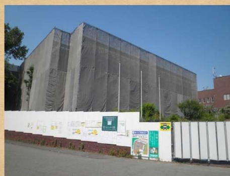
工事中の外観
