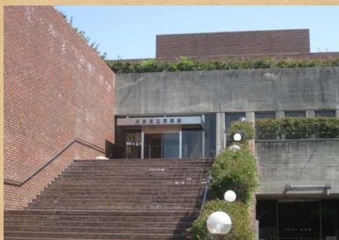
外階段（改修前）
