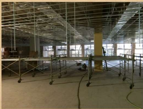
大閲覧室（工事中）
