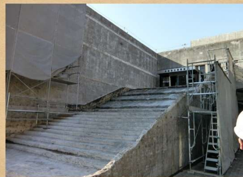
外階段（工事中）
