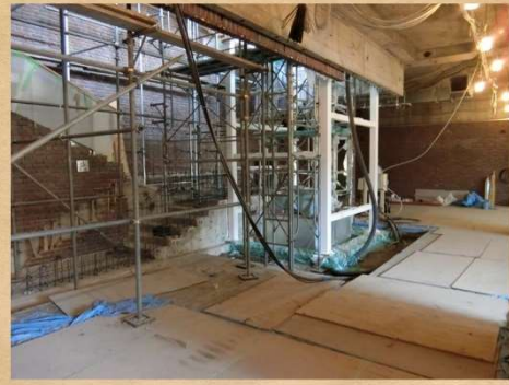
1階ホール（工事中）
