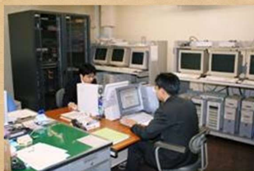
HALネットの更新 (新旧サーバー入れ替え作業のようす)
