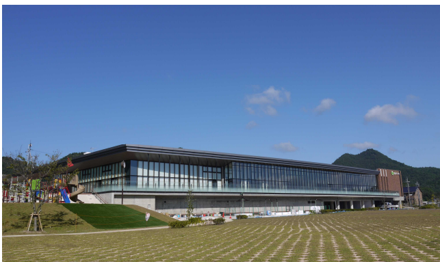
西脇市茜が丘複合施設全景
